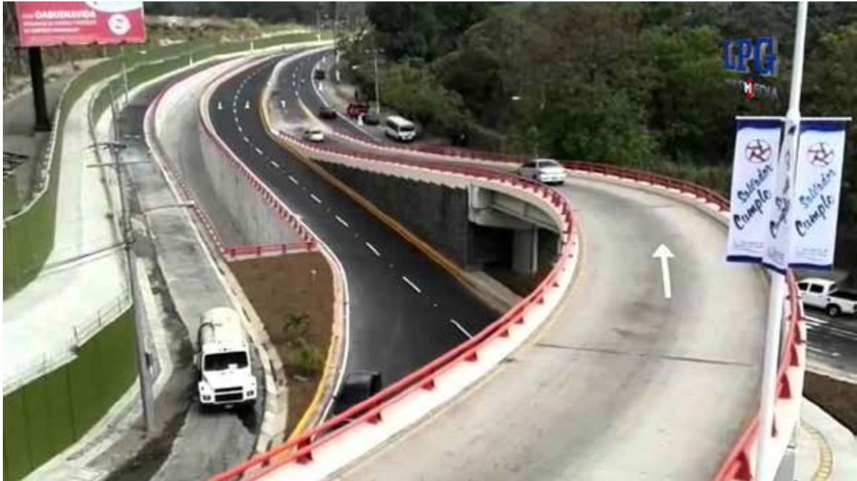
サンサルバドル市国連ロータリーの上を走る高架道路
